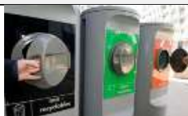
Fig. 24: Coleta seletiva em Barcelona, sistema subterrâneo, com tubos por até 5m, que são succionados com velocidade superior a 70 km/h e chegam até a unidade coletora já separados. Destas os resíduos são encaminhados para usinas de triagem, onde o papel, plástico e as latas são reciclados e o lixo orgânico se torna combustível
